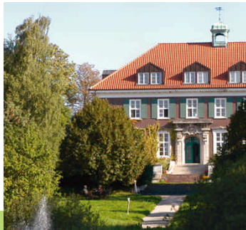
Das Hotel Gutshaus Stellhagen
